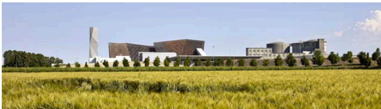
Fig. 2 - immagine tratta da https://www.ingenio-web.it/25712-powerbarn-un-edificio-che-ridefinisce-i-rapporti-tra-produzione-di-energia-e-territorio-agricolo . Centrale Powerban.
